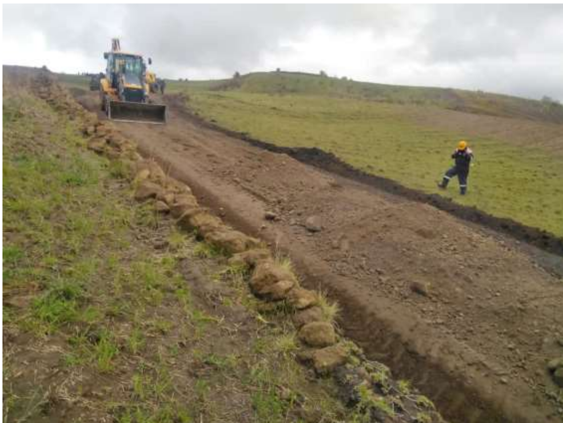
Foto 1. Sector de Murugallo - Verdepamba
